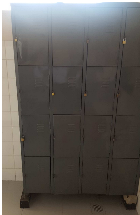
Figura 7 – Área de armários/vestiário.
