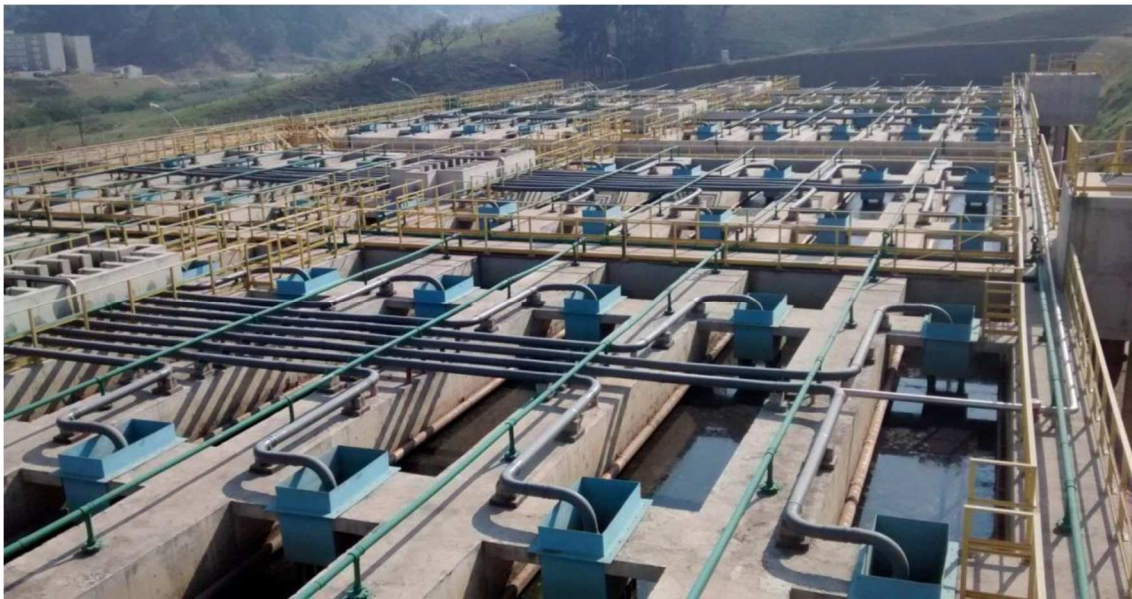
Figura 5: Reator UASB ETE Várzea Paulista- SP
