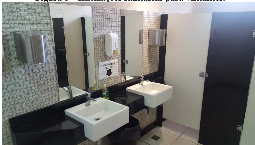
Figura 8 – Instalações sanitárias para visitantes.
