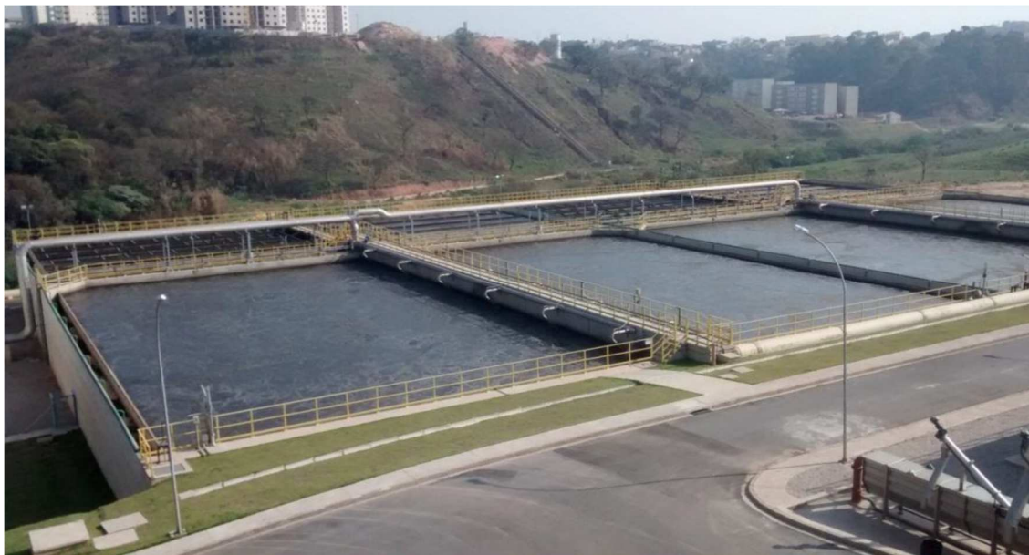
Figura 6: Reatores de lodos ativados
